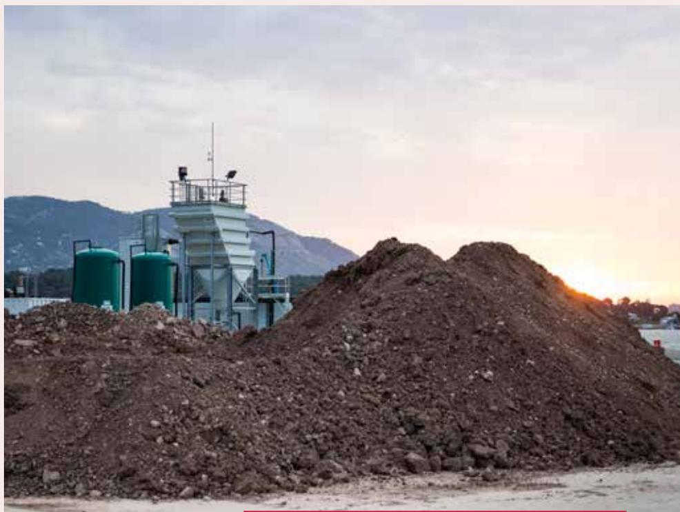
Les sédiments pollués sont séparés en une fraction de sable et en une fraction d'argile fine. La fraction de sable est nettoyée en vue d'être réutilisée.
